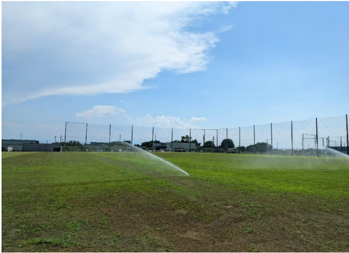
【スプリンクラーによる散水】
